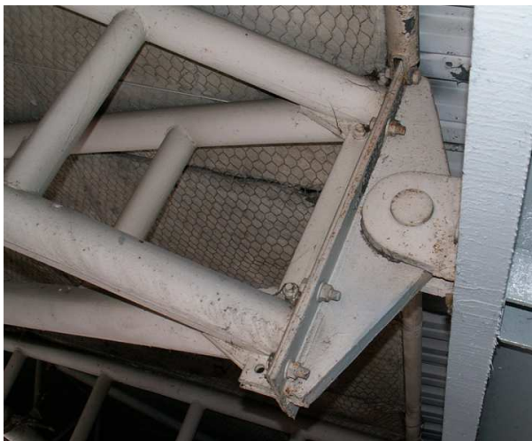
Obrázok 3 Pripojenie lamelového väzníka ku klbovému čapu
