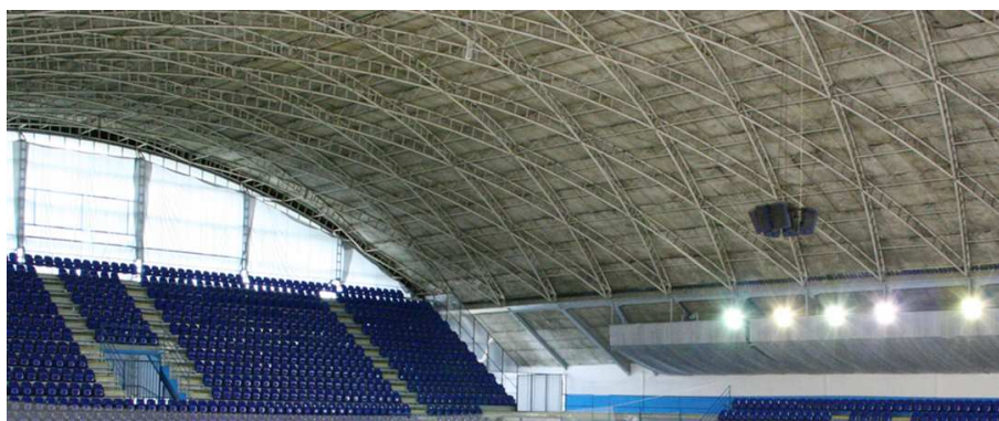
Obrázok 1. Pohľad na oceľovú nosnú konštrukciu strechy zimného štadióna (pôvodný stav)
