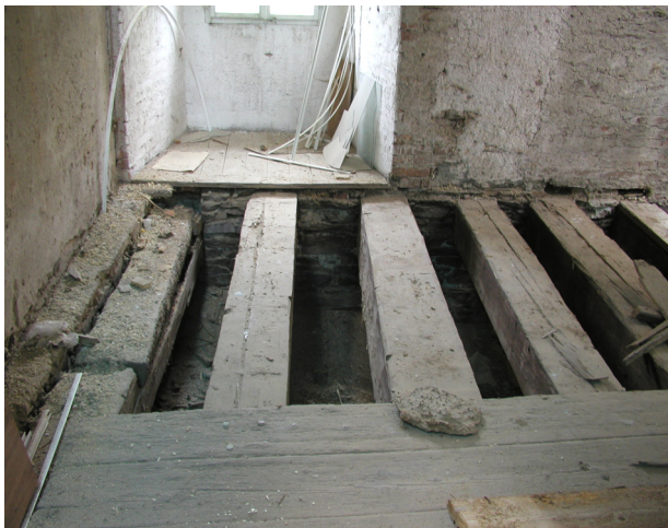
Obrázek 1 – nosné trámy před požárem.
