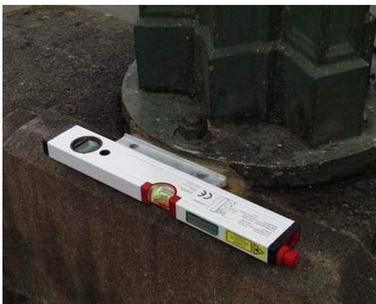
Foto 5: Uložení laseru pro kontrolu příčného vybočení
