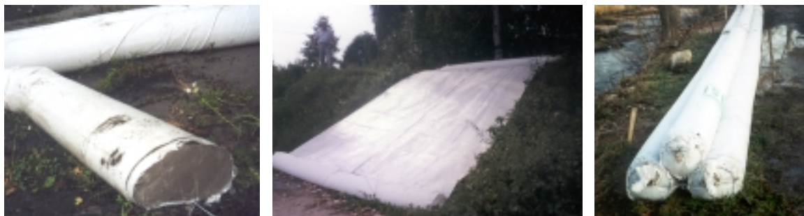
Obr. 2. Příklad praktického použití velkoobjemových vaků a matrací
